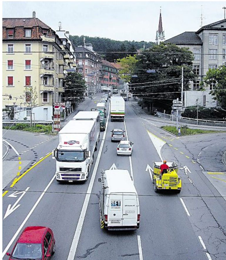
Rosengartenstrasse Herbst 2009 (mit Baustellenbetrieb Hardbrücke)
